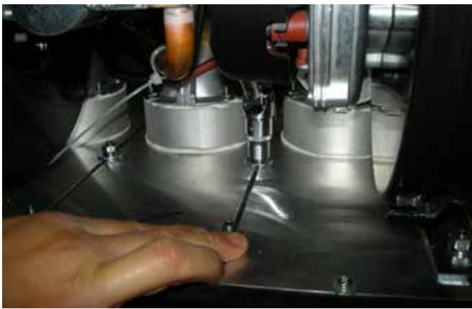
- Снять винты "А" с каждого элемента (торцевым ключом размером 13 мм)
