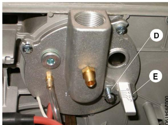
D - Винт регулировки диска пламени
